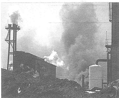
Мусор можно сжигать на специальных мусоросжигательных заводах. При этом удается уменьшить объём отходов и получить некоторое количество электрической энергии. Однако даже при самой совершенной технологии сжигания эти заводы загрязняют атмосферу. Кроме того, значительное количество образующейся золы требует последующего захоронения.
